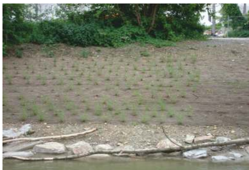
Geotessili - Sifor ® di juta posata lungo un corso d'acqua.
