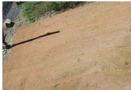
Geotessili - Sifor ® di cocco appena posata.
